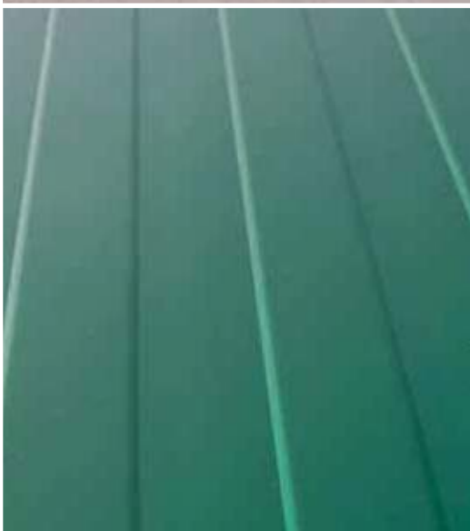
Détail du bardage
